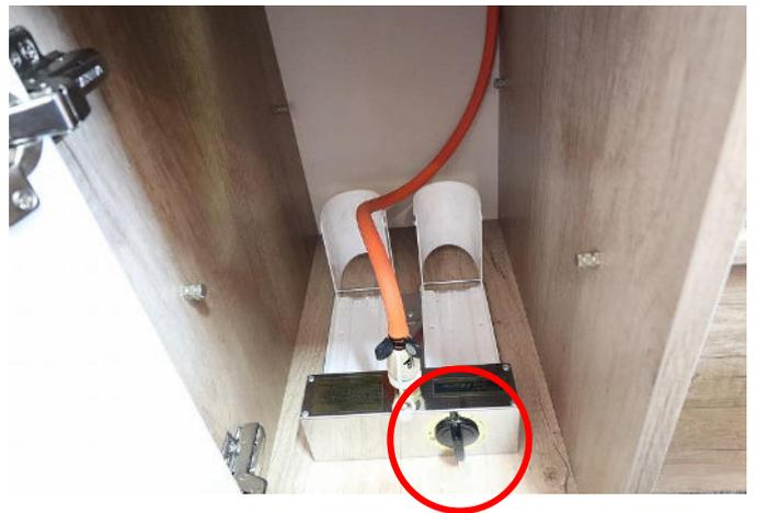
カートリッジをホルダーにセットし、元栓を開けます。使わないときは元栓を閉じてください。カートリッジはご持参ください
