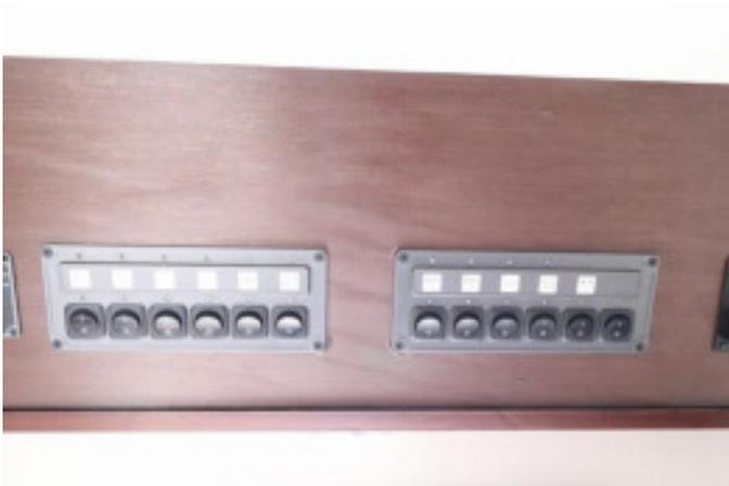
照明、冷蔵庫、水道ポンプ、天井換気扇等のスイッチ
