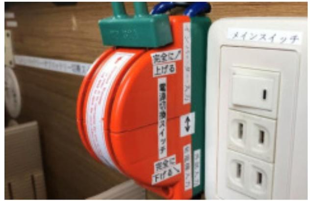
インバーター使用時は上、外部電源、発電機使用時は下にしてください。
