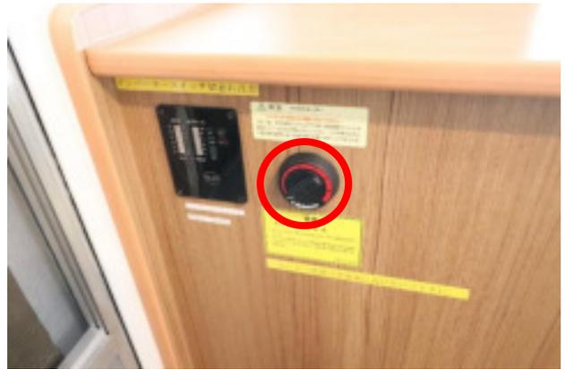
ダイヤルを回してスイッチ ON。使い始め 10 分間は最大で使用してください。温風の出る吹き出し口は床に向けないでください。
