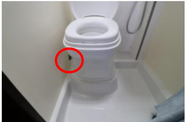
弁を開いて水を足します。洗浄レバーを上下して洗浄します。利用後は弁を閉じます。
