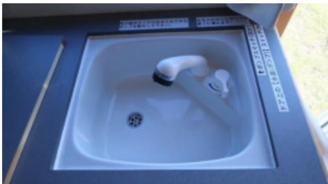
入口上の水道のスイッチを入れると水道ポンプが動きます。貸出時は水が入っていないのでポリタンクに水を入れてください。水が入っていない状態で水道ポンプを動かすとポンプが壊れます。
